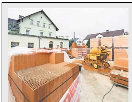
Stein auf Stein: Seit dem ersten Spatenstich am 6. September hat sich auf der Baustelle schon einiges getan. Stehen die Mauern, kann das Dach drauf. Foto: Steffen Unger
